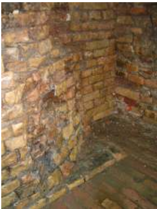
Afb.11. De afgeschuinde hoek van F34.
