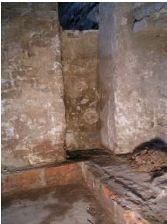
Afb.17. Uitgehakte sleuf in F19 voor een wiel
