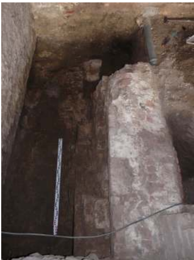
Afb.7. Muur F2/F6, vanuit zuidelijke richting
